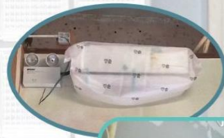
更換舊冷氣共11部
